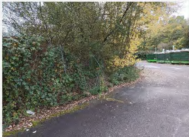
Clôture (poteau tordu) à proximité de l'accès PL
