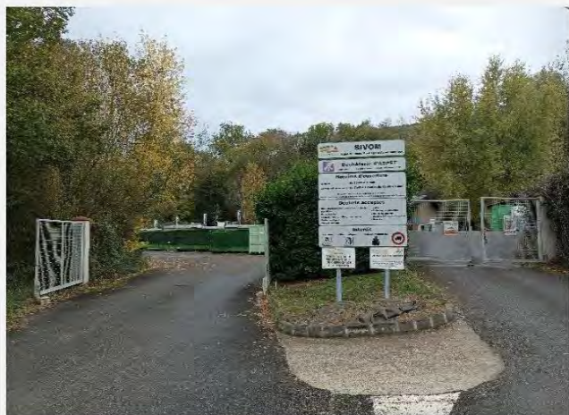
Accès à la déchèterie : PL (à gauche) et VL (à droite)
