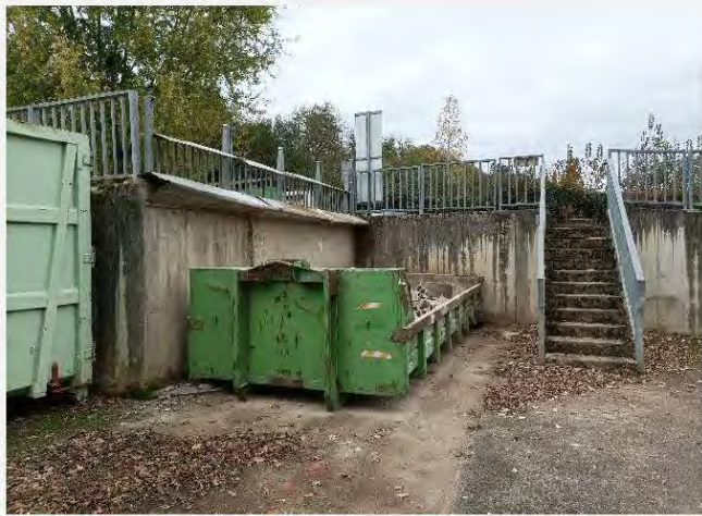
Bas de quai (gravats) et dalle béton
