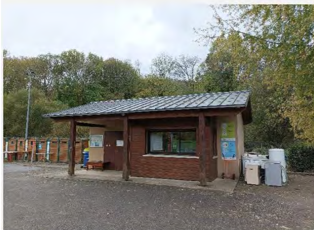
Local d'accueil, garage attenant et zone de dépôt DEEE
