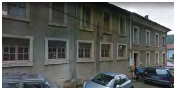
Façade nord actuelle
