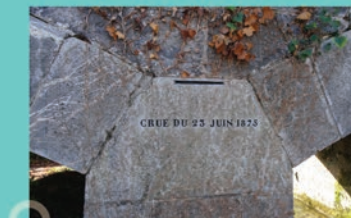
Repère gravé de la crue du 23 juin 1875 à Prat
