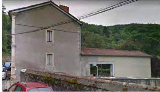
Façade sur entrée
