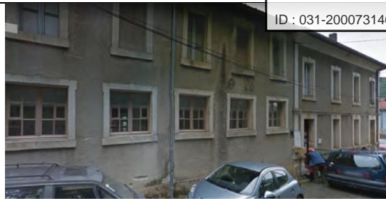
Façade nord actuelle
