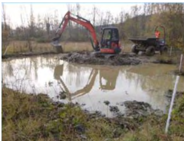
Travaux de terrassement.
