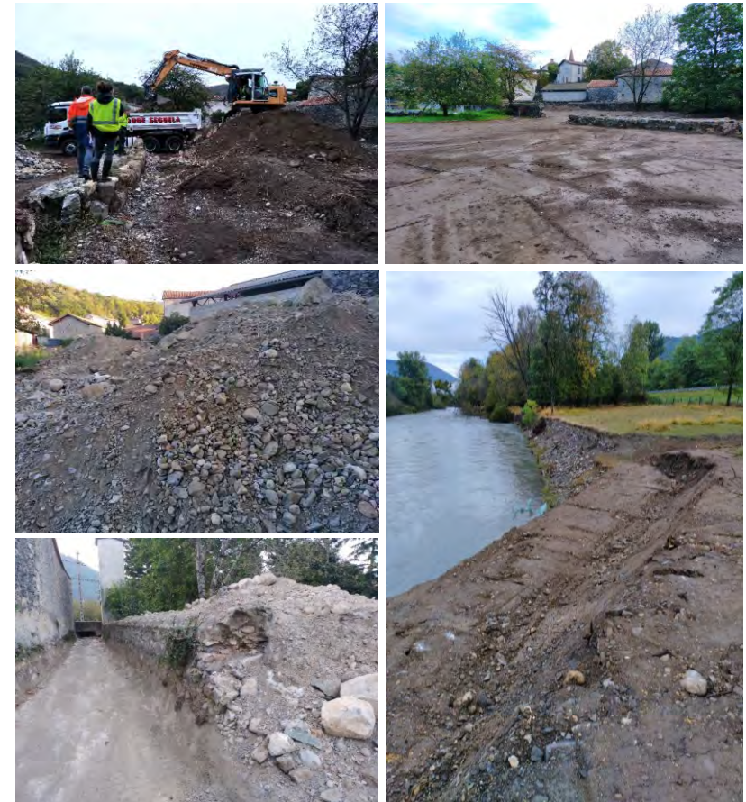
Photographies pendant les travaux de gestion sédimentaire sur la commune d'Ore
