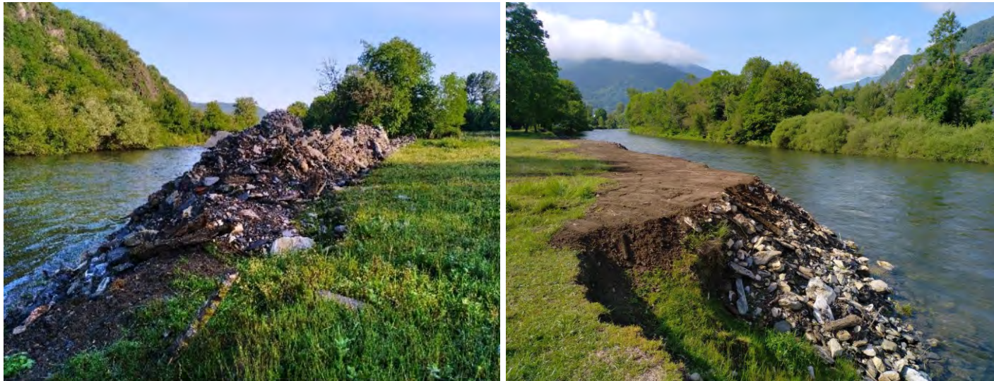
Photographies avant/après travaux de régilage des matériaux réinjectés à hauteur du terrain naturel en rive droite de la Garonne sur la commune de Chaum
