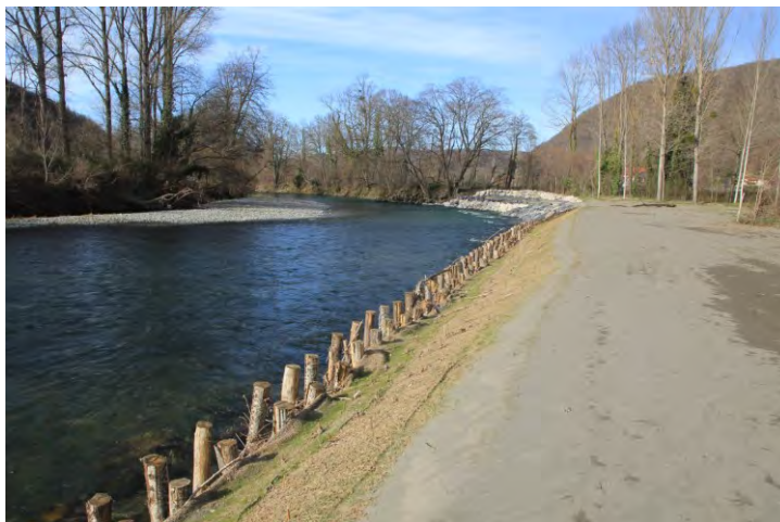
Garonne à Luscan : confortement de berge réalisé par la DIRSO en 2021
