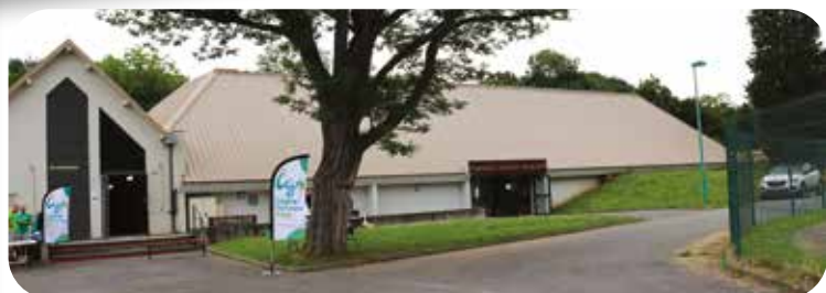
Gymnase intercommunal G. Marassé à Aspet
